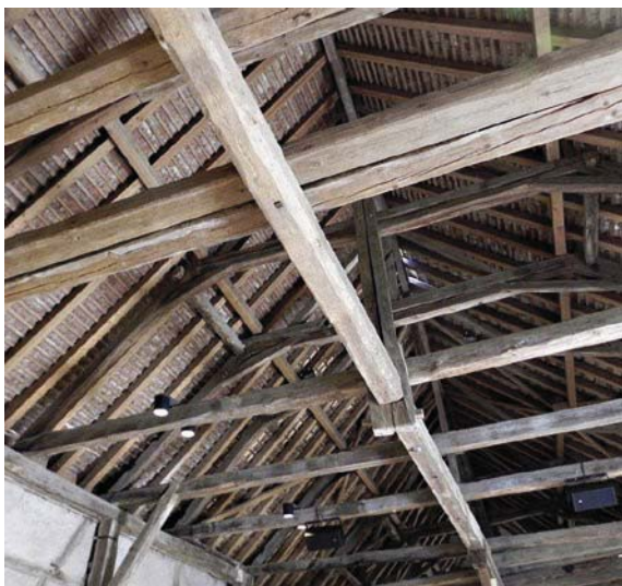
Abb. 1: Die einzelnen Bauetappen sind im Fachwerk des Dachstuhls gut zu erkennen.
